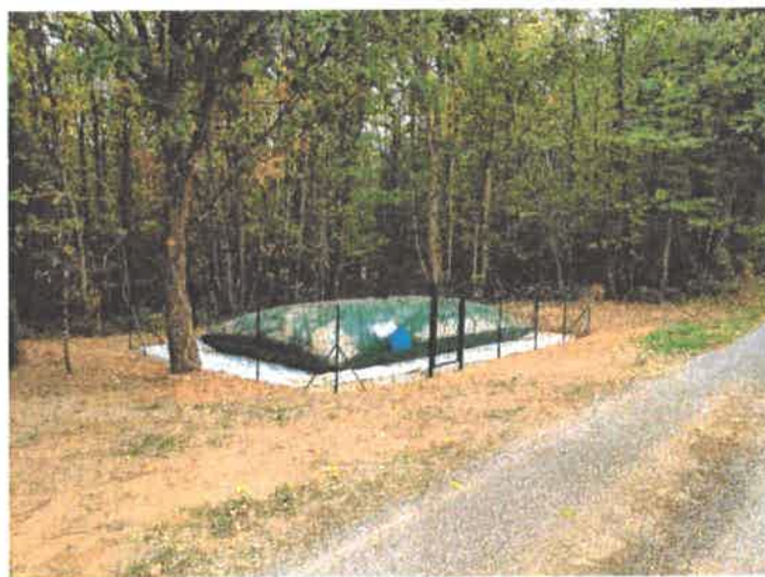
Bâche à eau remplie par les pompiers
