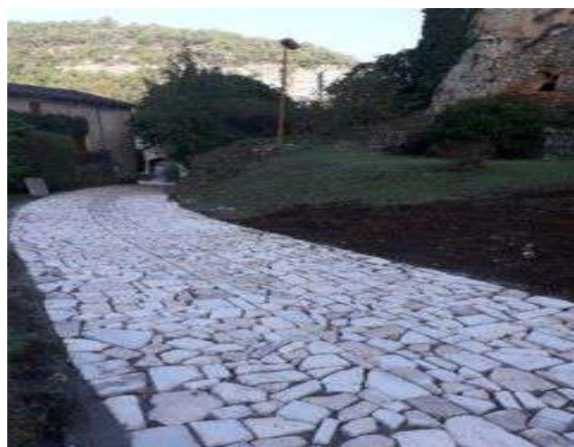
Pavage de la rue centrale
