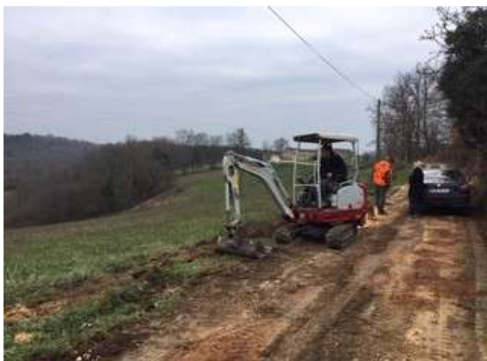
Travaux de terrassement
